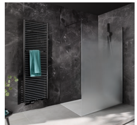
Nahe der Duschkabine (Bereich 2)
